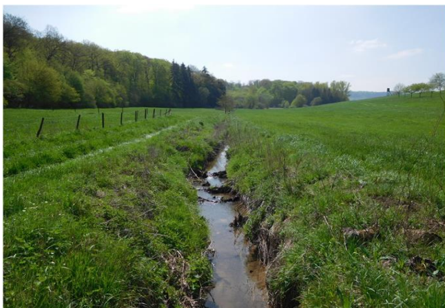
Foto gegen Fließrichtung
