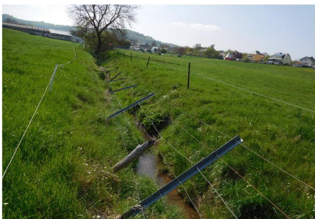
Foto gegen Fließrichtung
