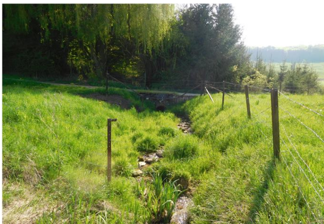
Foto gegen Fließrichtung
