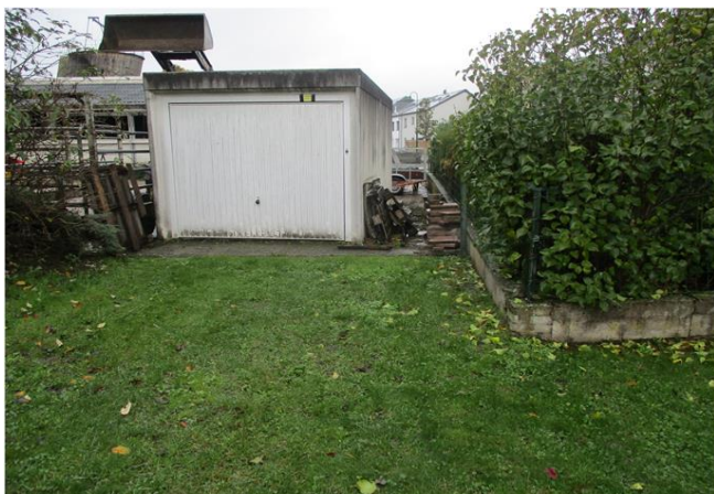
Foto gegen Fließrichtung
