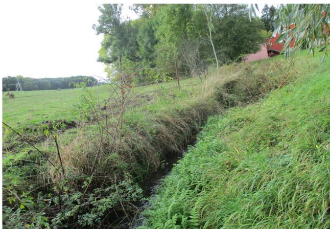
Foto gegen Fließrichtung
