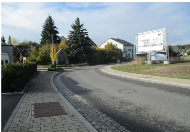
Foto gegen Fließrichtung
