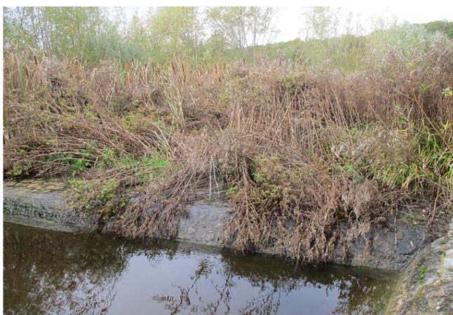
Foto gegen Fließrichtung
