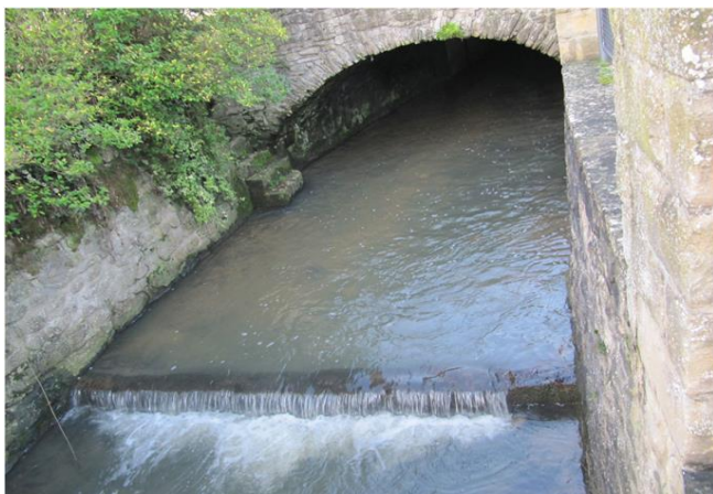
Foto gegen Fließrichtung
