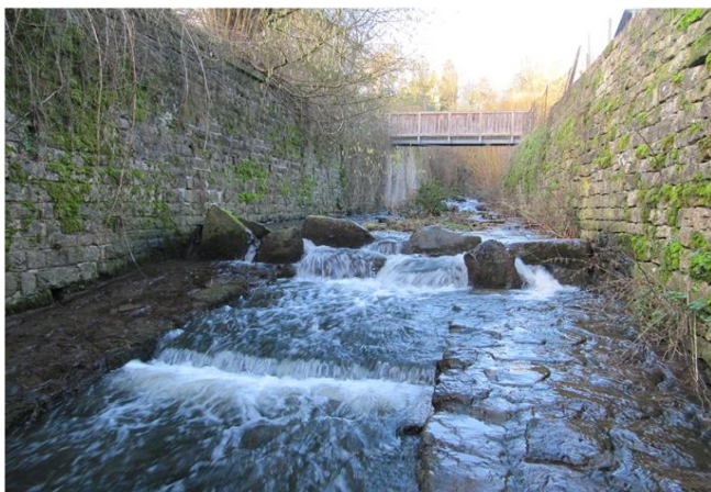
Foto gegen Fließrichtung
