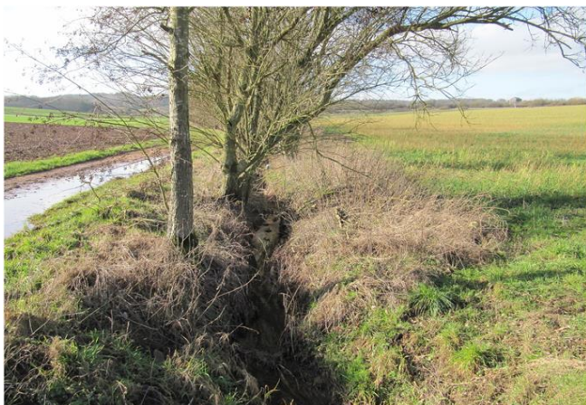
Foto gegen Fließrichtung
