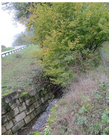
Foto gegen Fließrichtung
