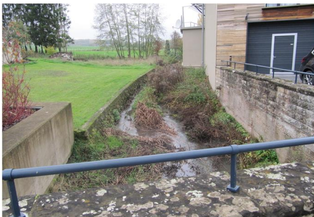
Foto gegen Fließrichtung
