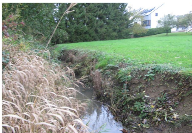
Foto gegen Fließrichtung
