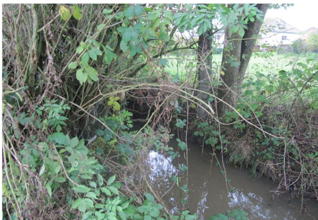
Foto gegen Fließrichtung
