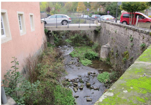
Foto gegen Fließrichtung
