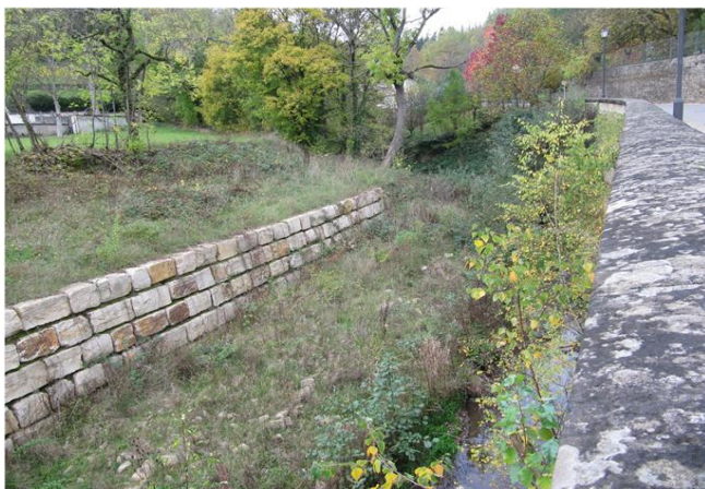
Foto gegen Fließrichtung
