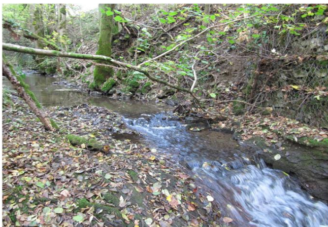
Foto gegen Fließrichtung
