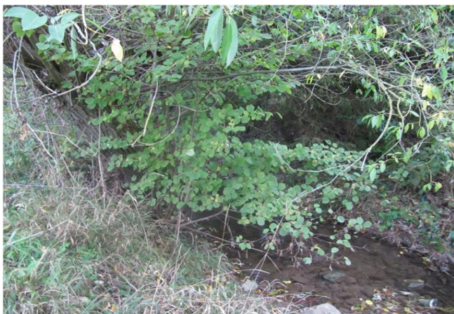
Foto gegen Fließrichtung
