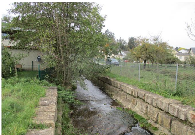
Foto gegen Fließrichtung
