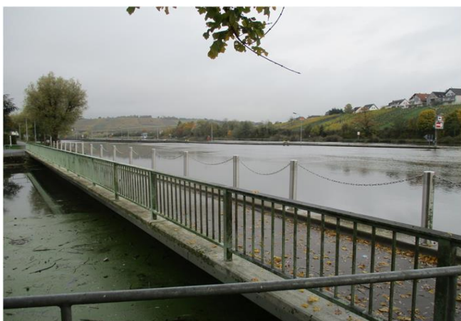
Foto gegen Fließrichtung
