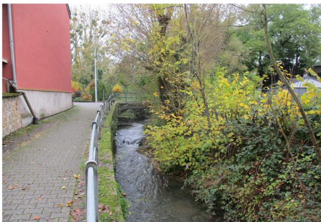
Foto gegen Fließrichtung
