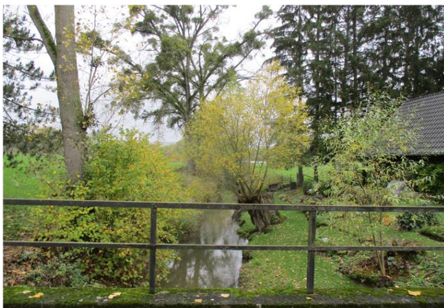
Foto gegen Fließrichtung
