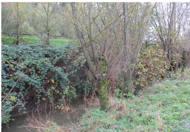
Foto gegen Fließrichtung
