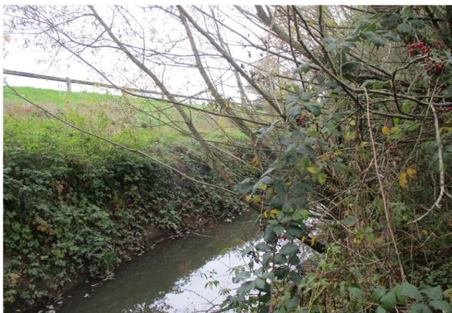
Foto gegen Fließrichtung
