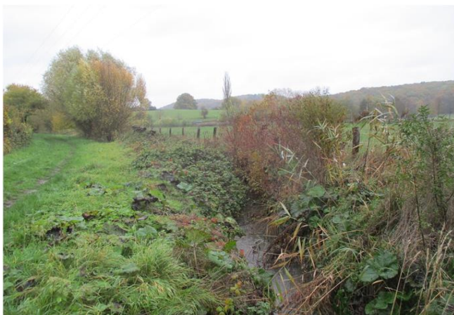
Foto gegen Fließrichtung
