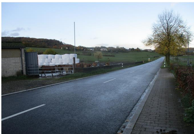
Foto gegen Fließrichtung
