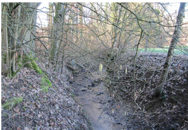
Foto gegen Fließrichtung
