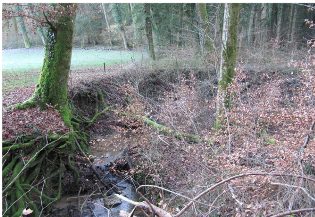
Foto gegen Fließrichtung
