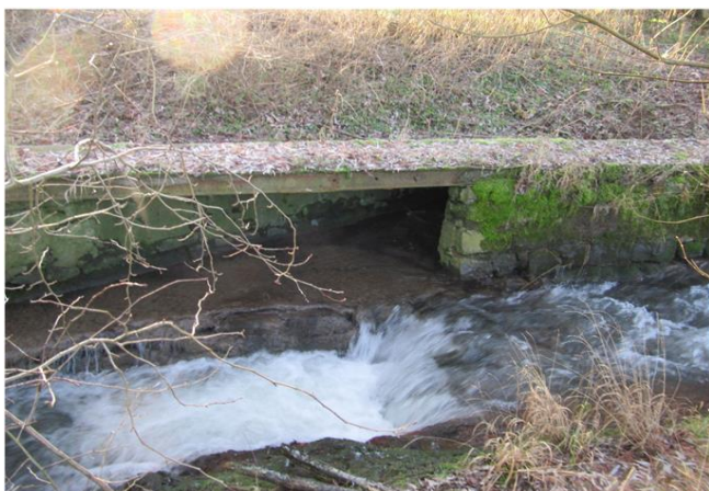
Foto gegen Fließrichtung
