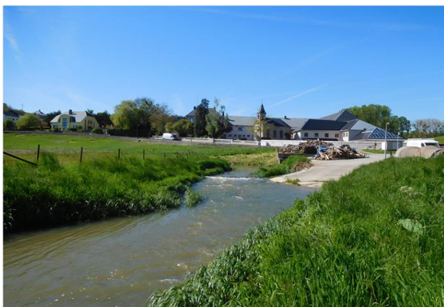
Foto gegen Fließrichtung
