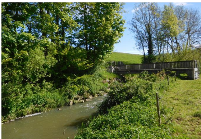
Foto gegen Fließrichtung
