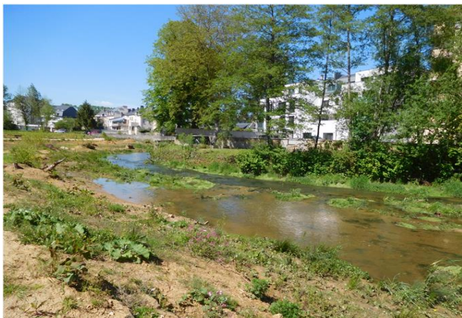
Foto gegen Fließrichtung
