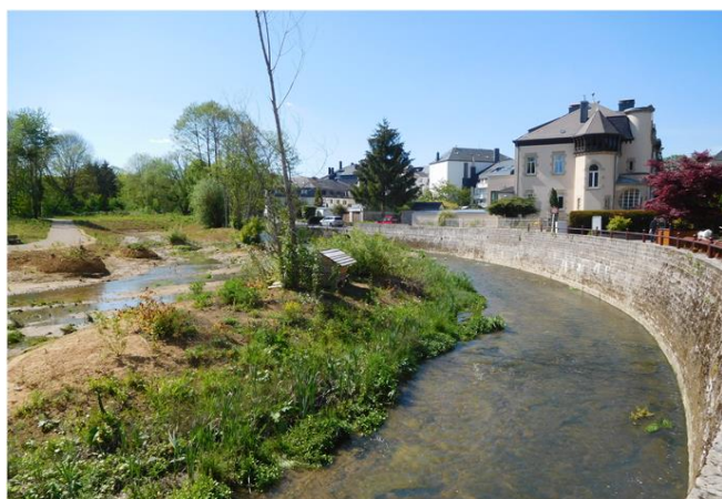
Foto gegen Fließrichtung
