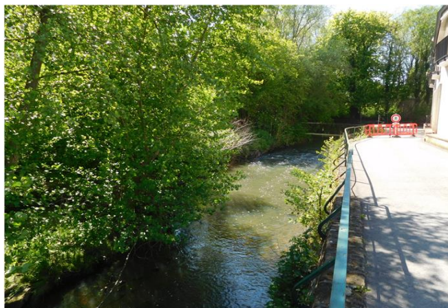
Foto gegen Fließrichtung
