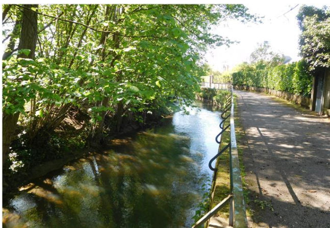
Foto gegen Fließrichtung
