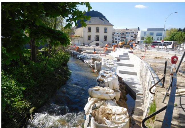
Foto gegen Fließrichtung
