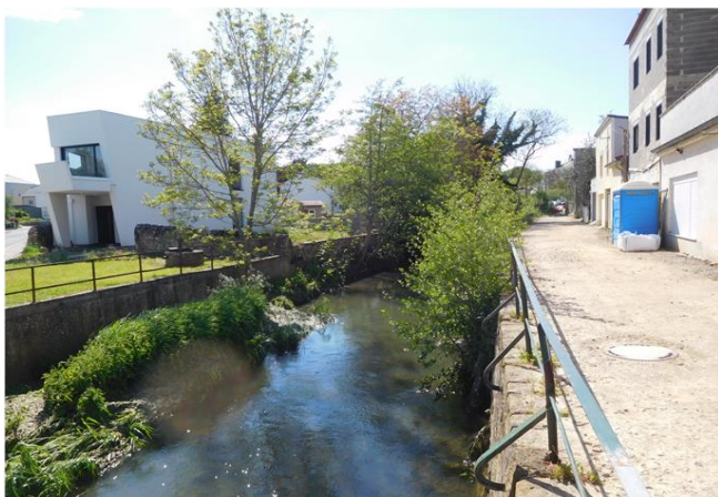
Foto gegen Fließrichtung
