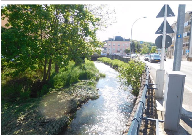
Foto gegen Fließrichtung
