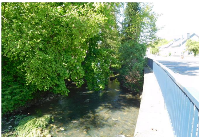
Foto gegen Fließrichtung
