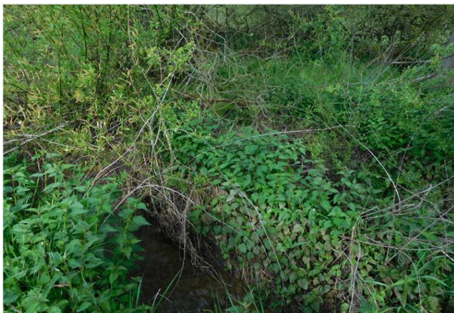
Foto gegen Fließrichtung
