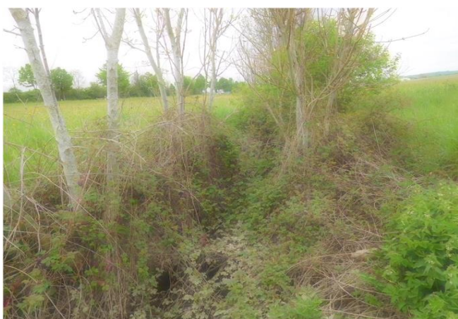
Foto gegen Fließrichtung
