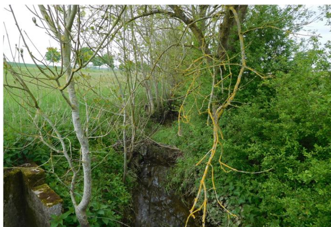
Foto gegen Fließrichtung
