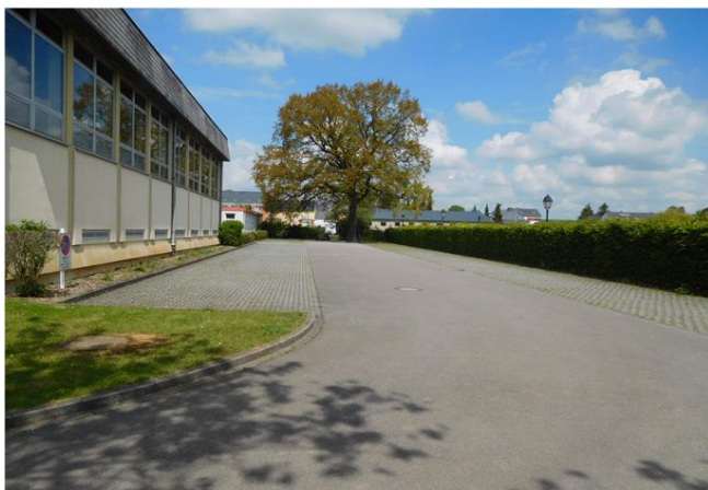
Foto gegen Fließrichtung
