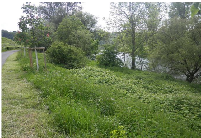
Foto gegen Fließrichtung
