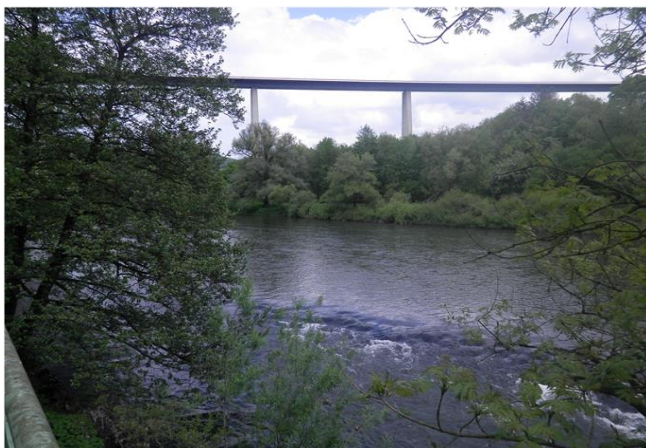
Foto gegen Fließrichtung
