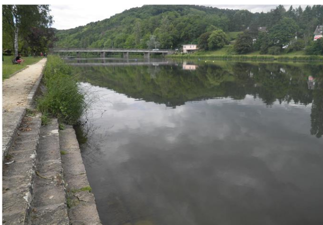
Foto gegen Fließrichtung
