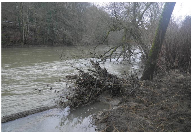
Foto gegen Fließrichtung
