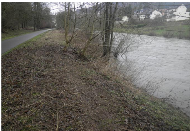
Foto gegen Fließrichtung
