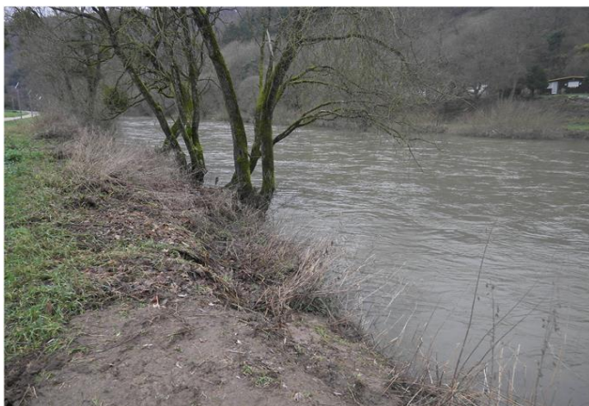
Foto gegen Fließrichtung
