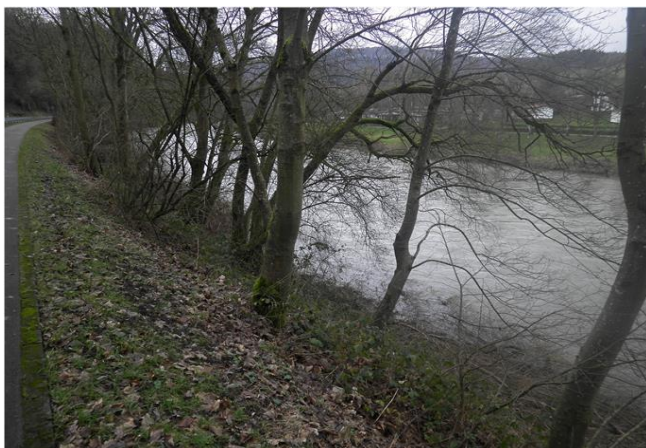
Foto gegen Fließrichtung
